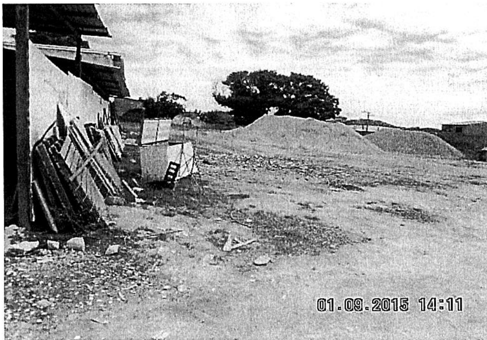
Foto 40 : Área interna do Terreno 8
