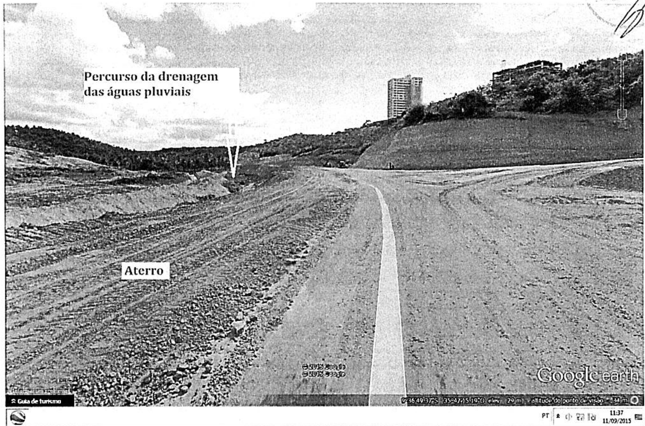
Foto 22: Condição do Terreno 6 durante obras da Av. Pierre Chalita
