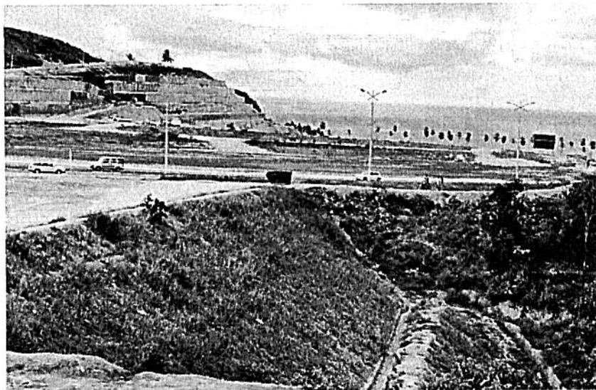
Avenida Josefa de Melo, tendo ao fundo o antigo lixão, onde muro de contenção desabou no início de maio
