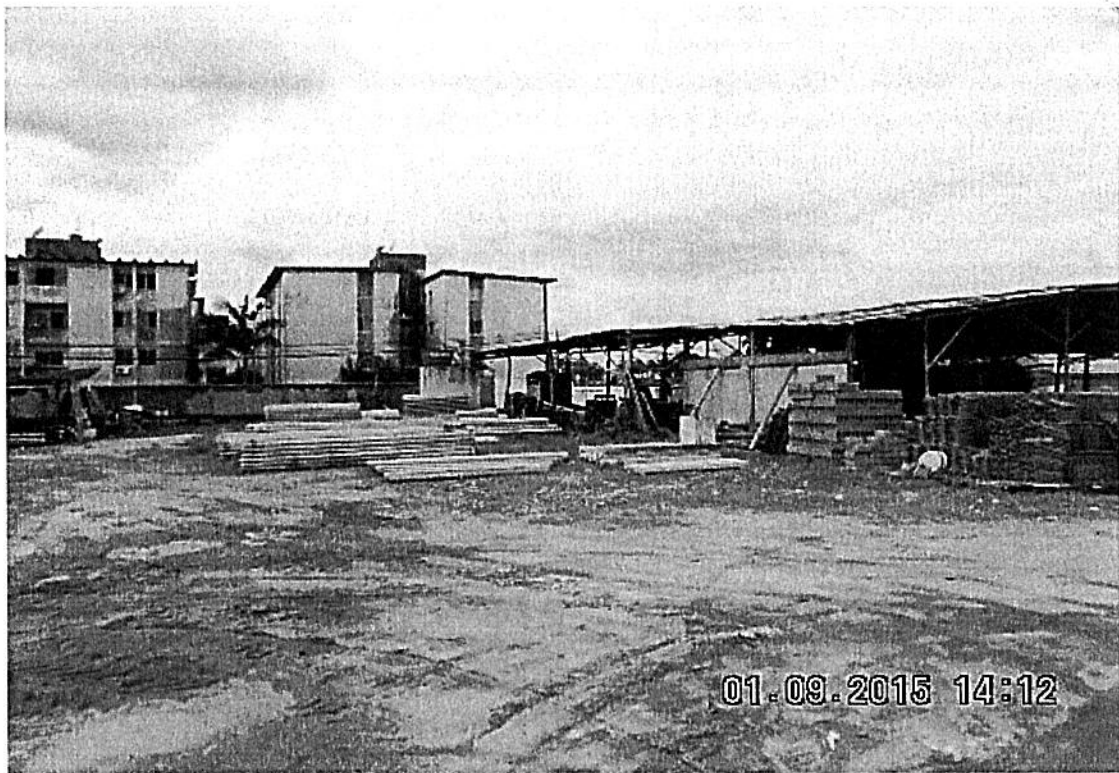
Foto 41 : Área interna do Terreno 8
