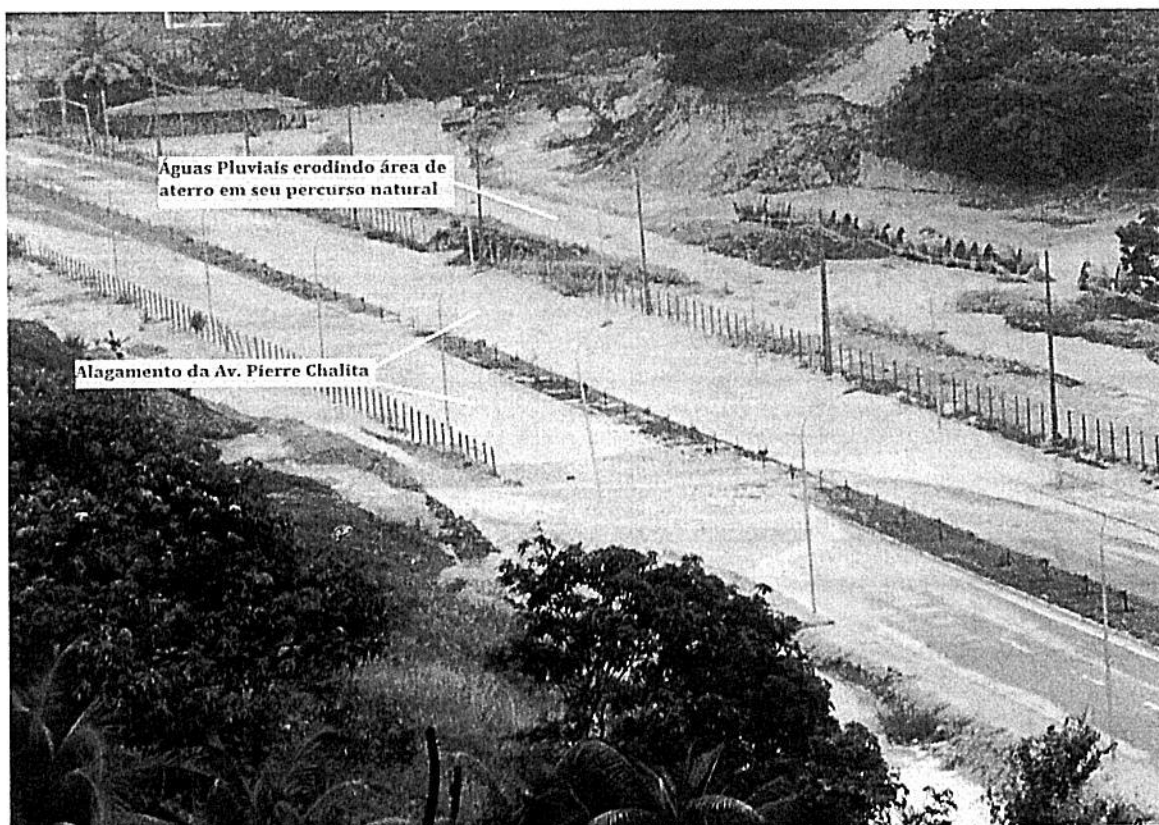
Foto 25: Condição da Av. Pierre Chalita em períodos de chuva
